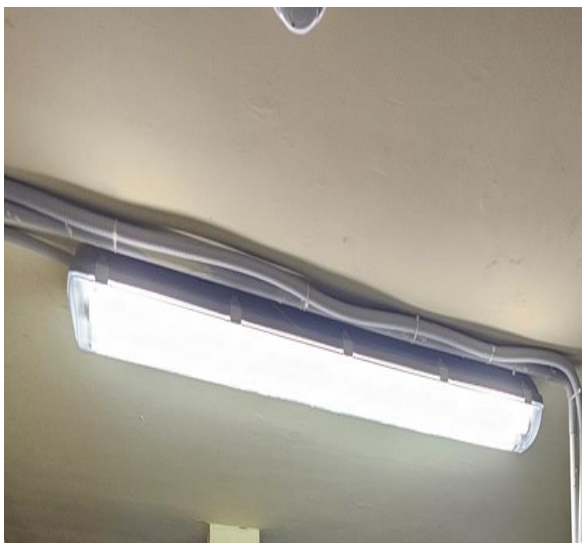
5. Pav. Patalpų apšvietimas
