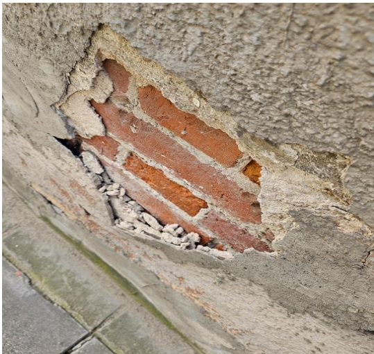
1. Pav. Pastato išorinė siena
